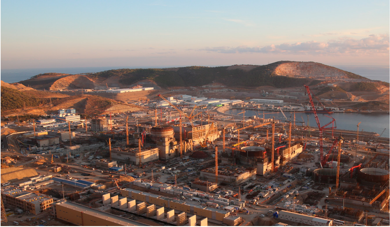
Şekil 1: Akkuyu NGS Sahası
